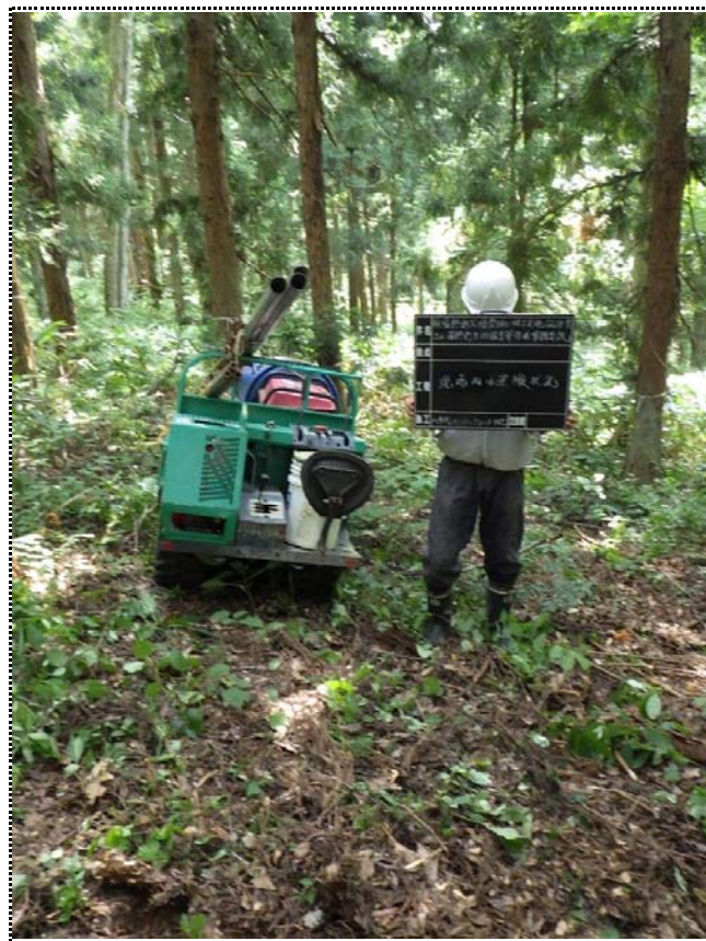
現場内小運搬状況
