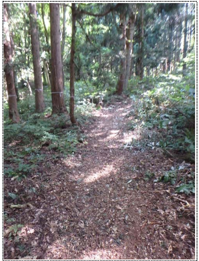
搬入路伐採状況
