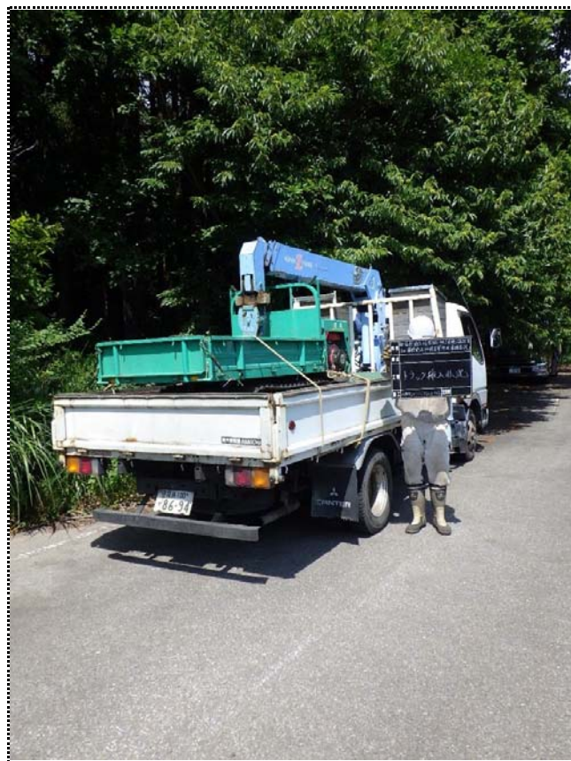
トラック搬入状況
