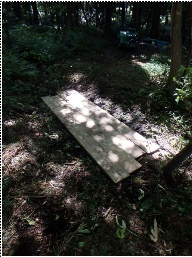
段差部養生状況
