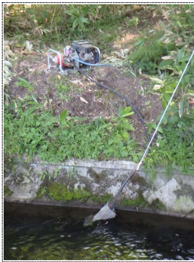
ポンプ設置状況
