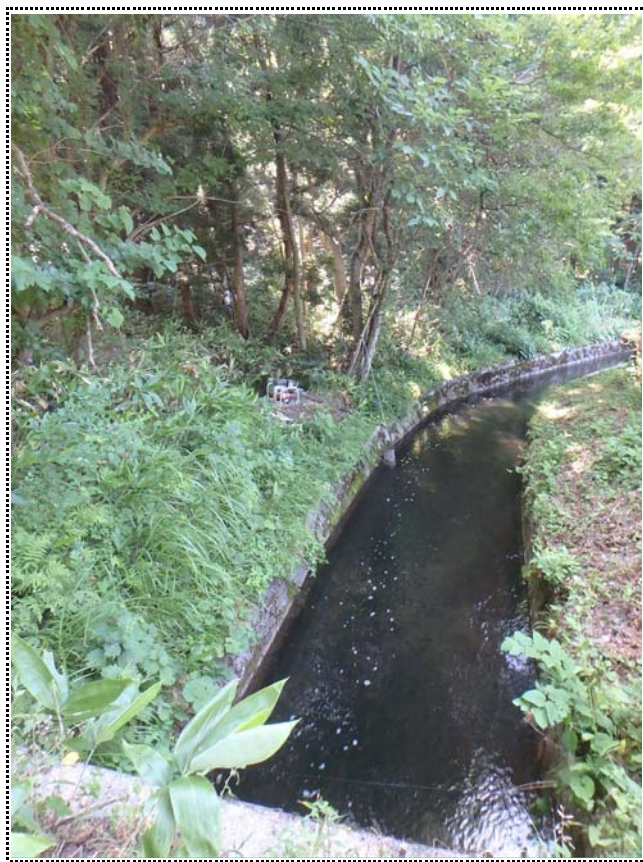
ポンプ設置状況
