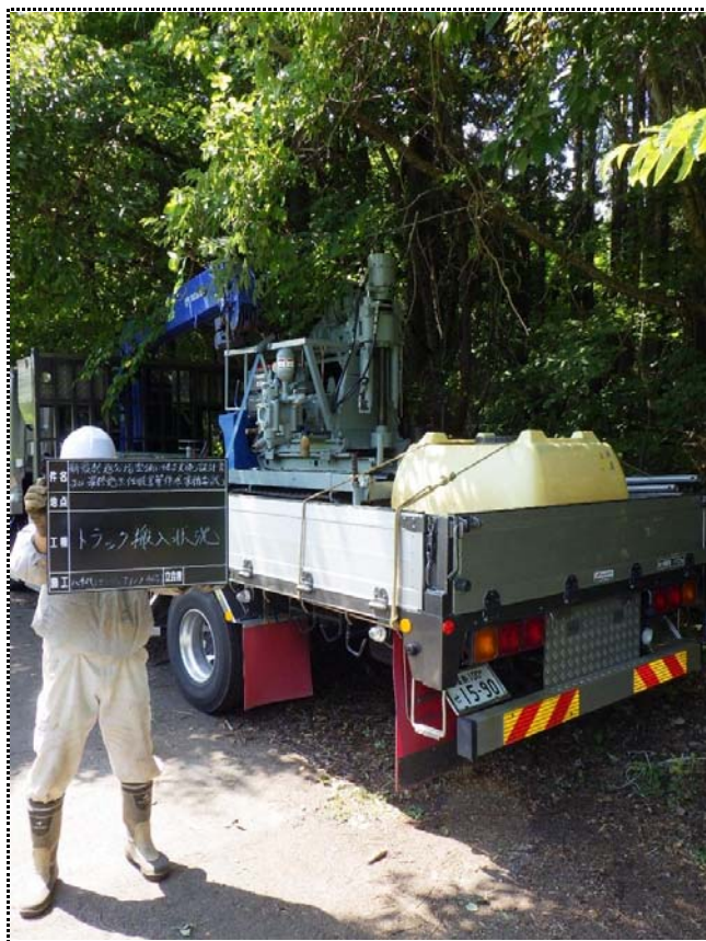
トラック搬入状況
