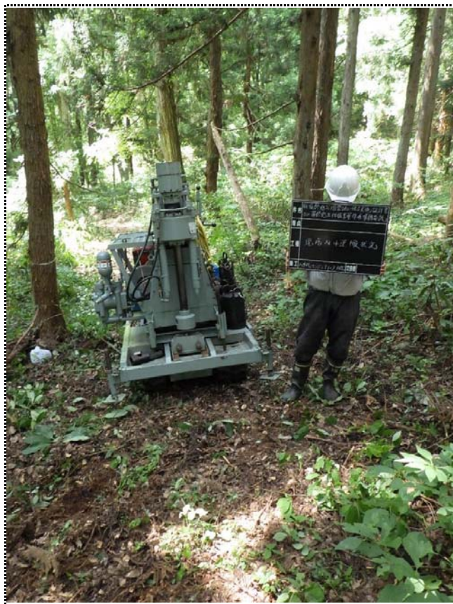
現場内小運搬状況
