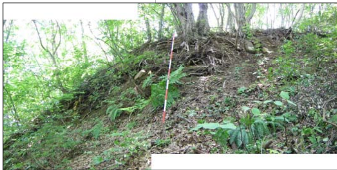
16 Φ0.5m大の安山岩転石を混入した露頭。基質は粘土質砂～粘性質砂状で軟質である。
