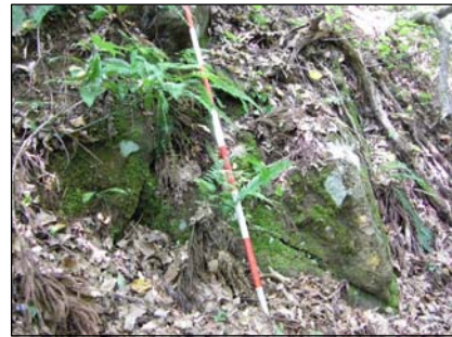
13 布廊堀沿いの切土部に見られる安山岩溶岩の転石状露岩部。
