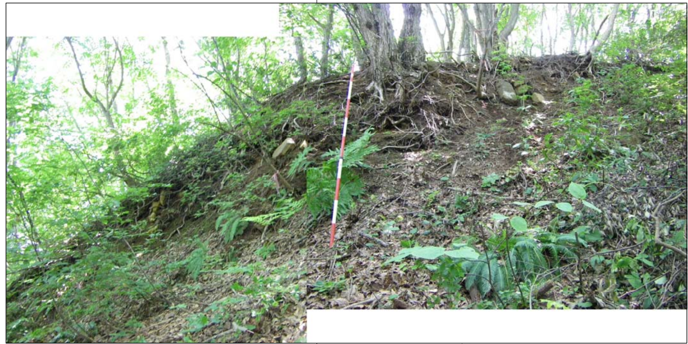
18 Φ0.5m大の安山岩転石を混入した露頭。基質は粘土質砂～粘性質砂状で軟質である。
