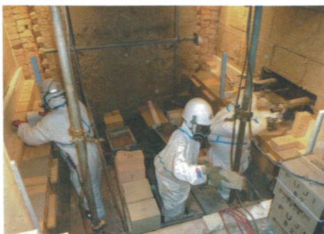
焼却炉内部のレンガ修繕の様子
