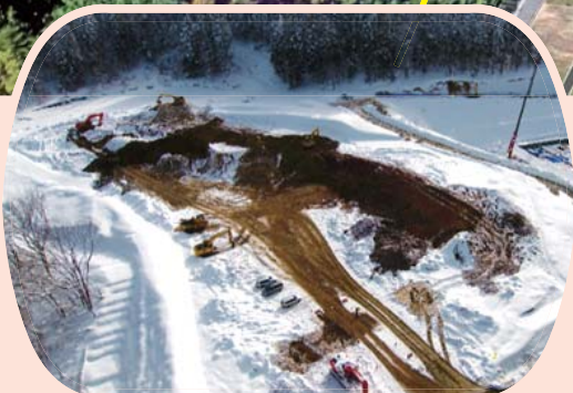
埋立地部分の掘削
