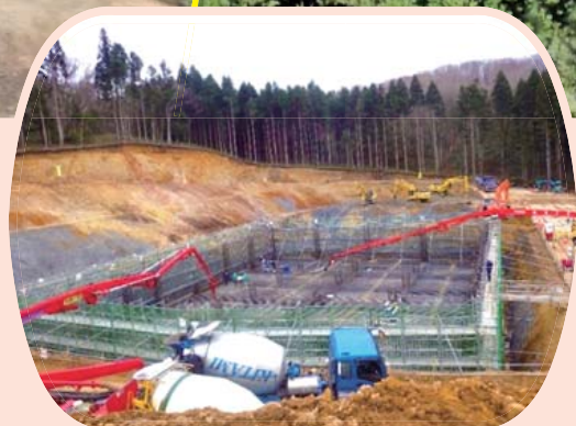
浸出水処理施設工事の状況
