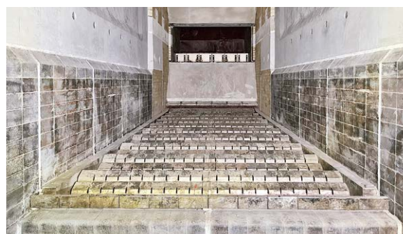
焼却炉内部の状況
