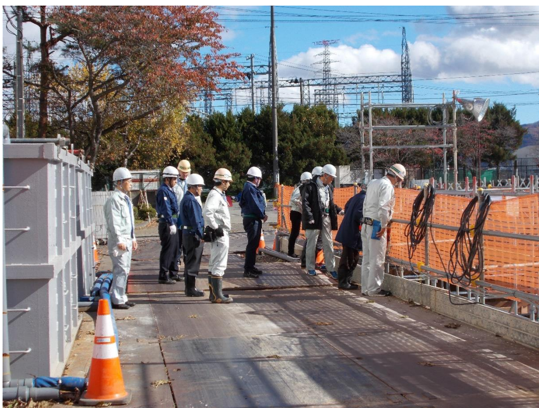
現地実査 令和元年11月15日
