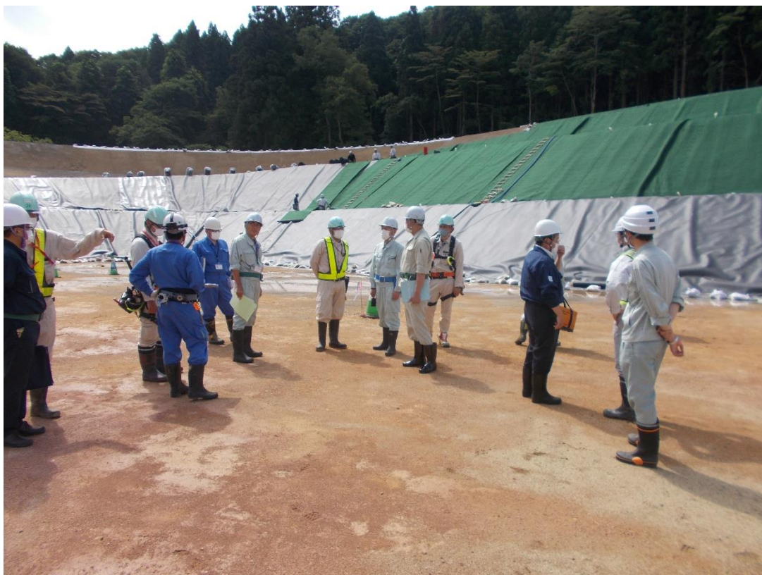
令和3年7月30日 現地実査（遮水シートの施工確認）
