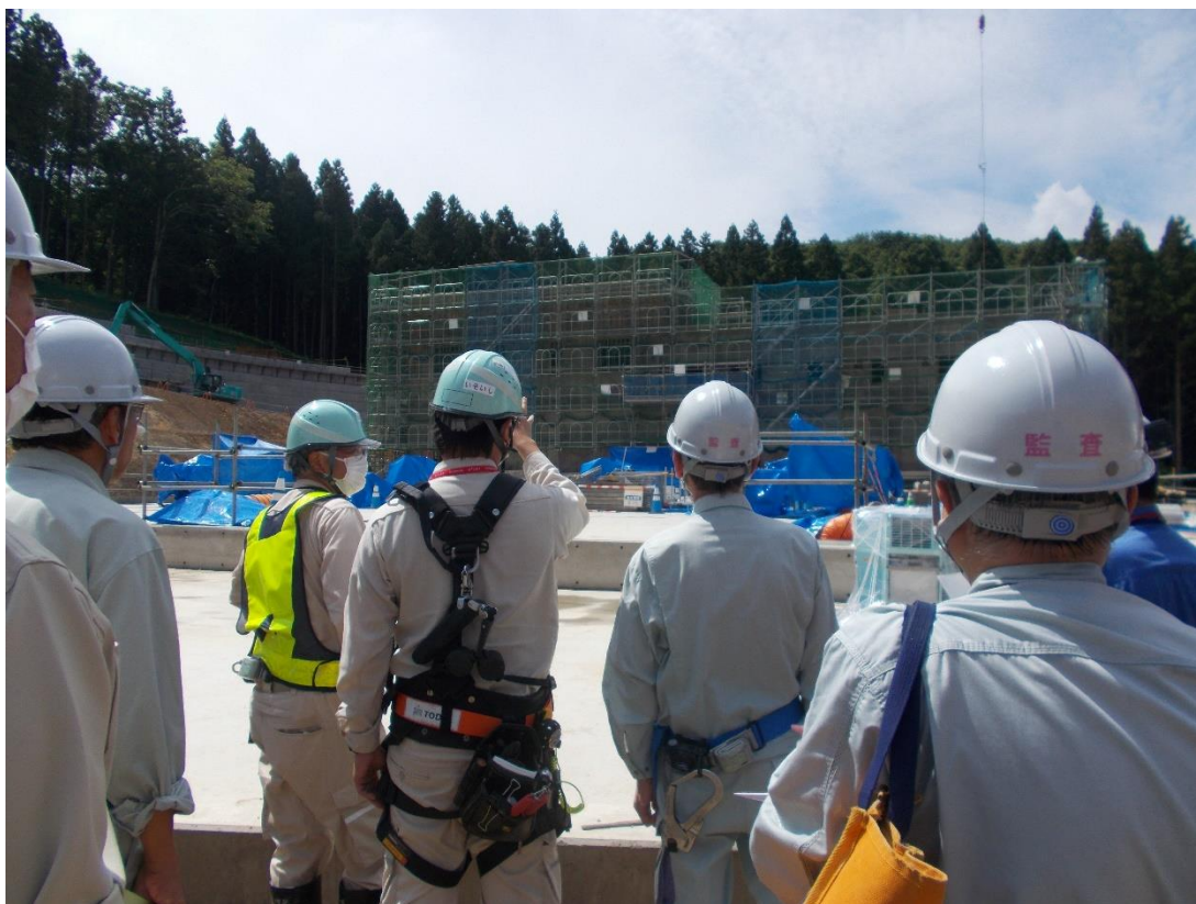
令和3年7月30日 現地実査（浸出水処理施設施工確認）
