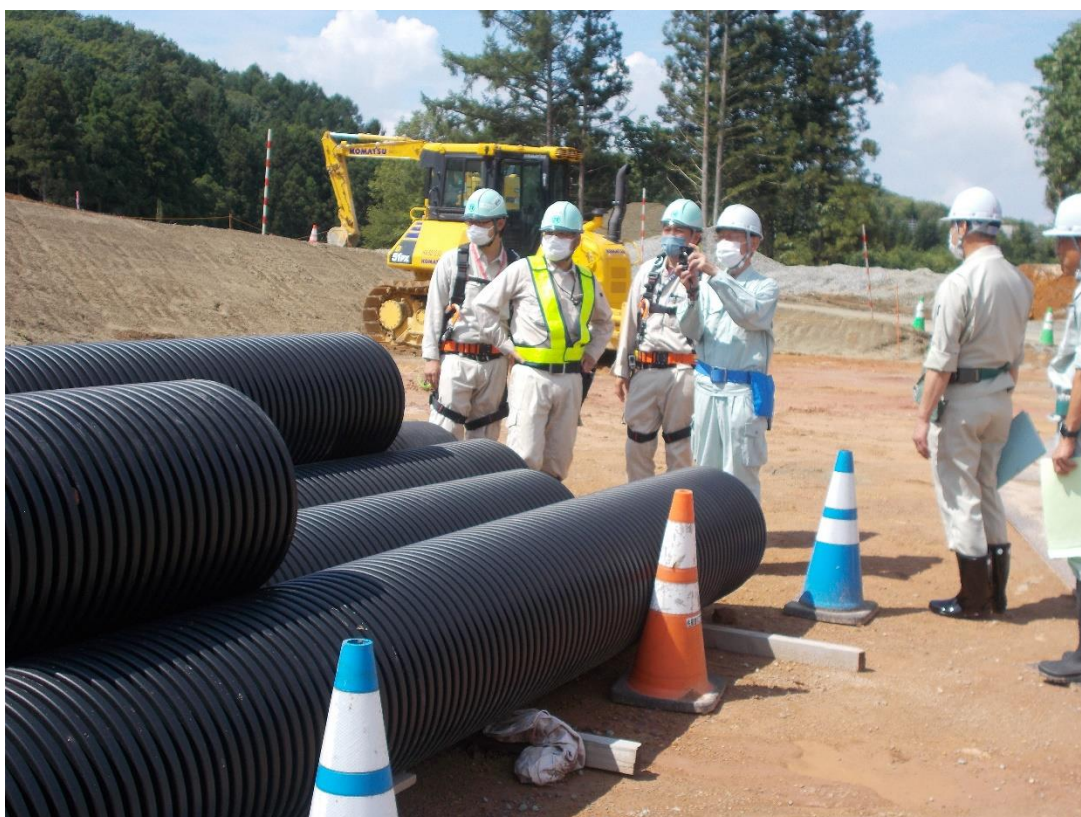
令和3年7月30日 現地実査（使用材料の確認）
