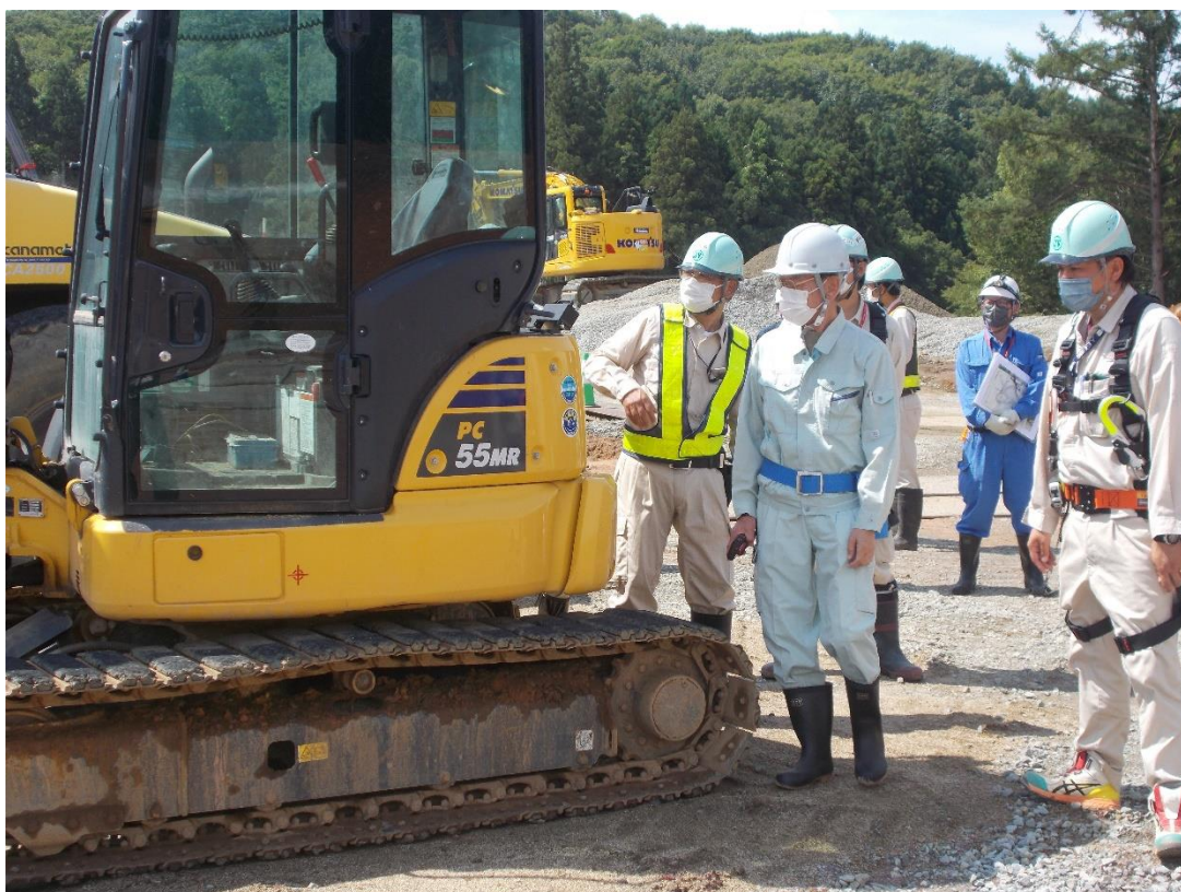
令和３年７月30日 現地実査（建設機械の確認）
