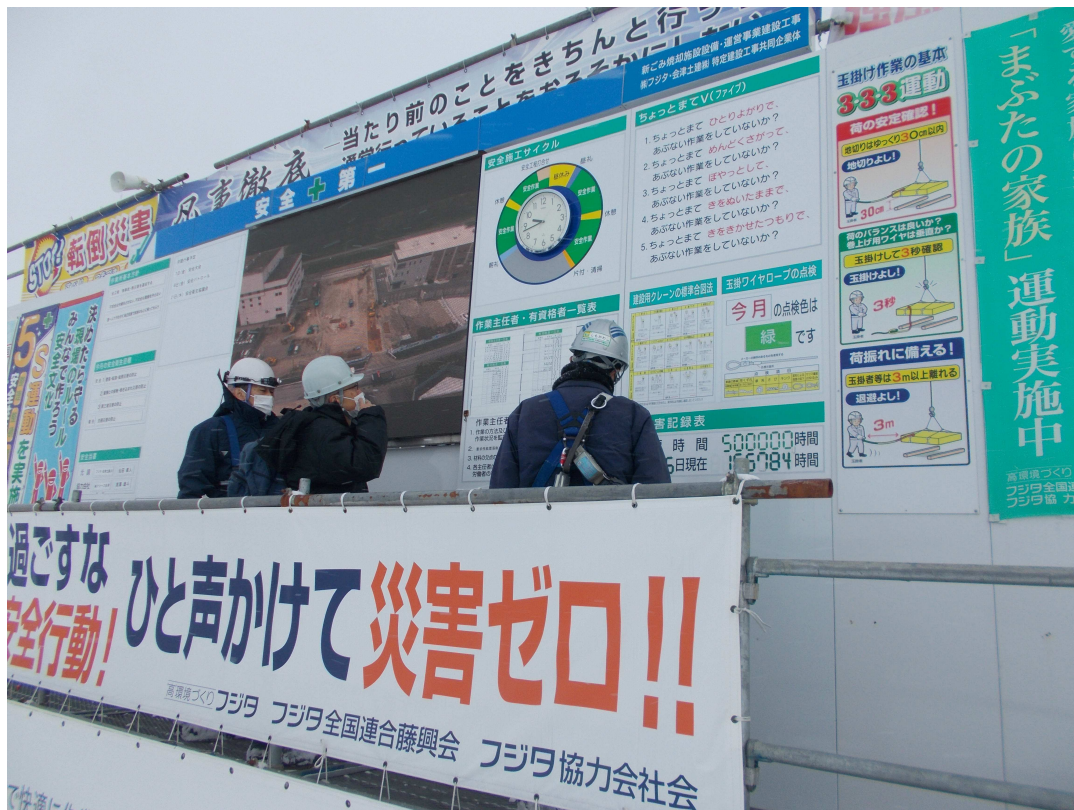
現地実査 令和6年1月16日 現場標識類の掲示状況
