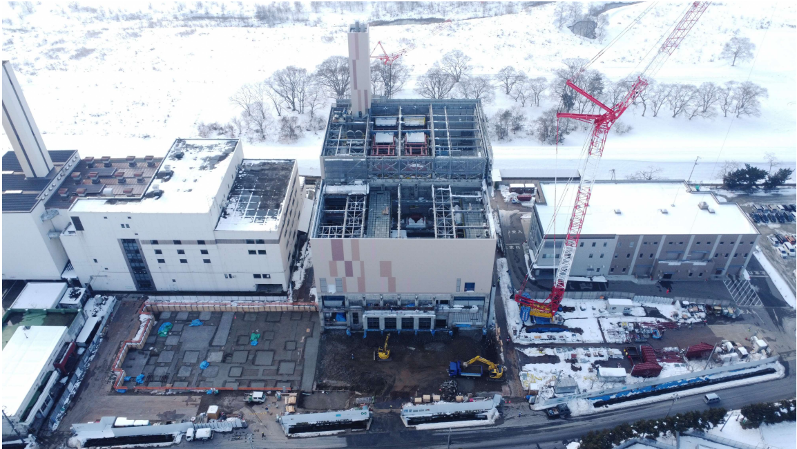
工事箇所全景（工事受注者提供写真）
