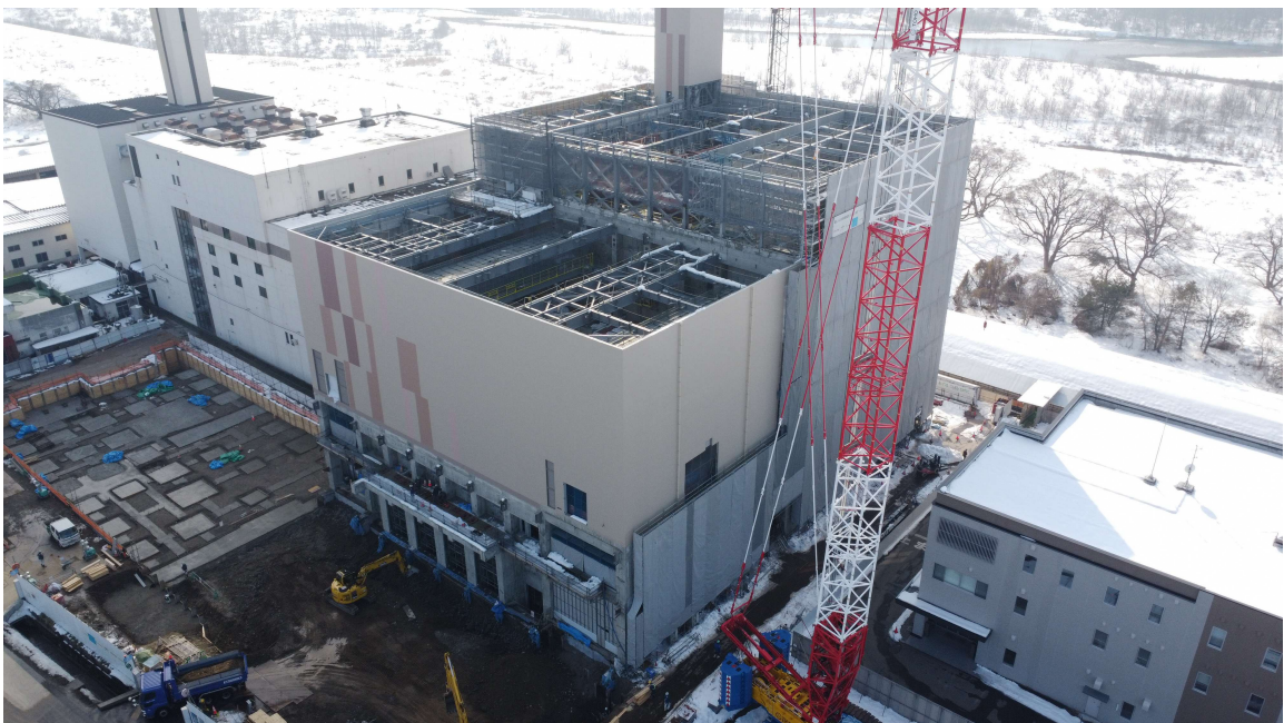
工事箇所全景（工事受注者提供写真）
