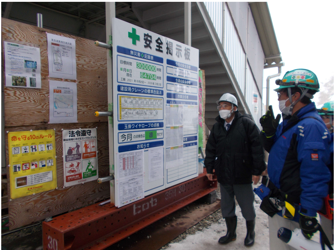
現地実査 令和7年1月22日 現場標識類の掲示状況
